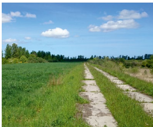
Składowisko odpadów paleniskowych w Rewie
