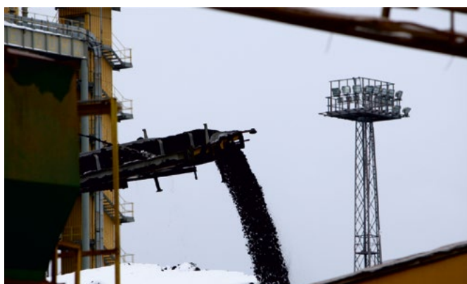
Plac składowania węgla w Elektrociepłowni Gdańskiej
